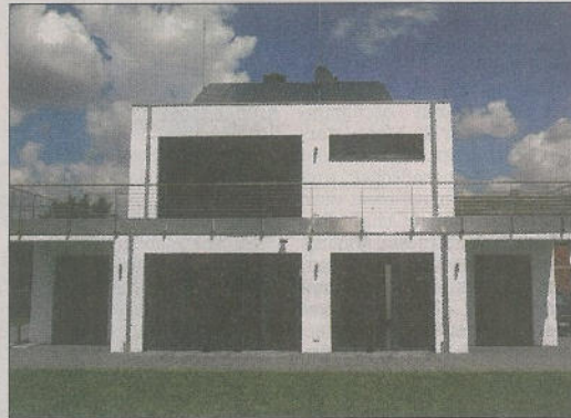
Die Architektenkammer NRW suchte das Wohnhaus in der Falkenburger Straße 25 als vorbildlich für Euskirchen aus.
