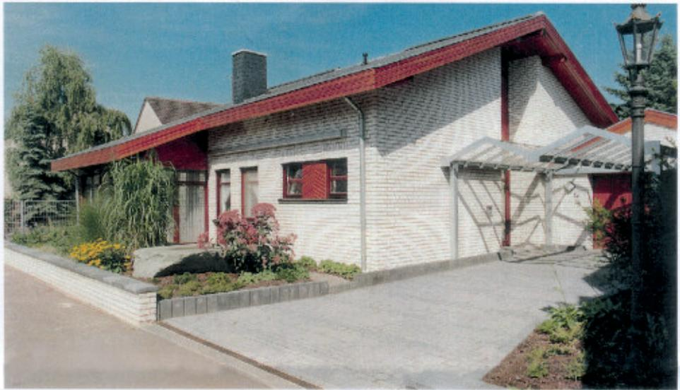
Ton-Flachdachziegeln. Die Außenholzbeleidung ist aus nordischen Fichte-Profilhölzern, wärmegeklämmt und hinterlüftet, in das Verblendermauerwerk eingelassen. Die Außentüren entsprechen in Material und Farbton den Mahagoni-Holzisolierfenstern, die Haustür ist nach Architektenentwurf, an das Haus angepaßt, gebaut worden. Die Garage ist in Form, Dachneigung und Material dem Wohnhaus angeglichen.
