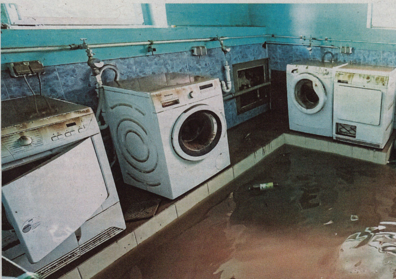
Elektrogeräte, die im Wasser standen, sollte ein Fachmann überprüfen.
