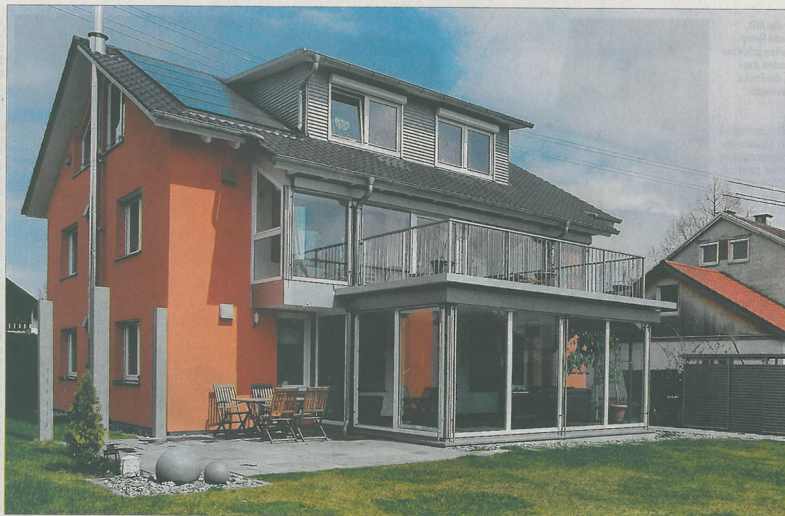
Große Wirkung: Nach der Sanierung braucht dieses Einfamilienhaus 91 Prozent weniger Energie. (Foto: dpa)
